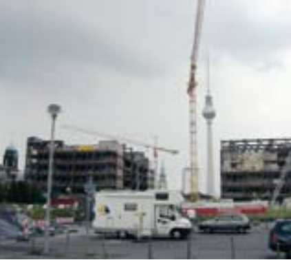
ABRISS 2007. Genussvoll wird das Gebäude jahrelang vor den Augen der Öffentlichkeit zerstört. Demolition; 2007. The building is demolished with a kind of sadistic pleasure over the course of many years.
